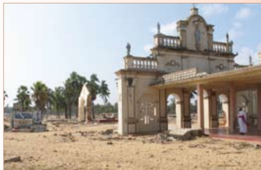
Reconstruire les églises détruites : une priorité pour l'AED (Sri-Lanka)
